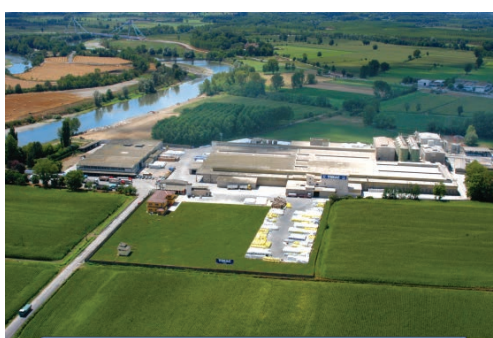
Stabilimento di Ripalta Arpina (CR)
