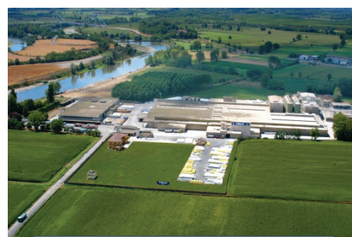
Stabilimento di Ripalta Arpina (CR)
